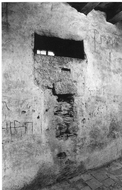
5: Fenster an der Westwand des Turmgefängnisses.
