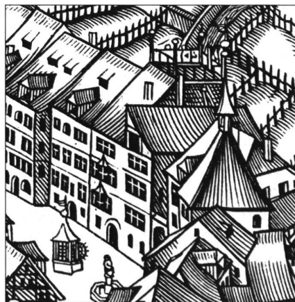
27: Murervedute: «Rechberg» (Neumarkt 6). Einzigartig für das 16. Jahrhundert ist die luftige «Zinne» auf dem Hauptdach.
