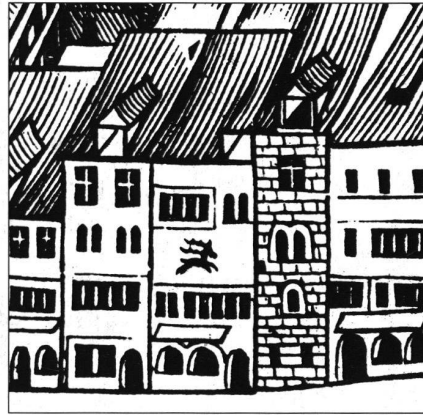
3: Murervedute: «Hirschli» (Niederdorfstrasse 3). Unter dem sprechenden Hauszeichen bringen ein fünfteiliger Fensterwagen und ein Pfostenfenster Licht in die beiden gassenseitigen Räume des 1. Obergeschosses.
