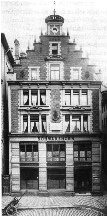
24: «Schwarzes Horn», vgl. Abb. 22 und 23. Die Fassade nach dem durchgreifenden Umbau von 1880. Foto Moser vom 10. Januar 1899.
