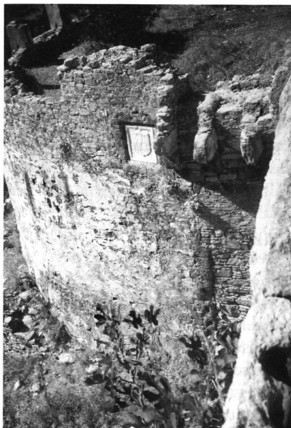
9: Sými, Kástro, grosses Rondell mit Wappen des Grossmeisters Emery d'Amboise, rechts neben dem Wappen Maschikuli-Konsolen, Blick von der antiken Ringmauer.
