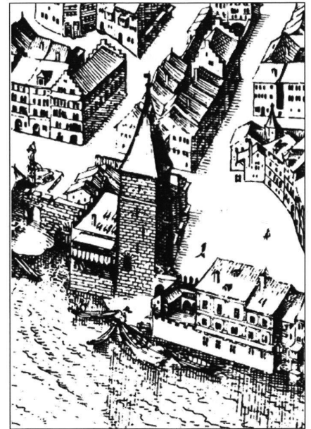
1: Der Salzturm an der Schiffflände (wie Titelbild), ein in die Rheinmauer integrierter, 1829 abgebrochener städtischer Wehrturm.
