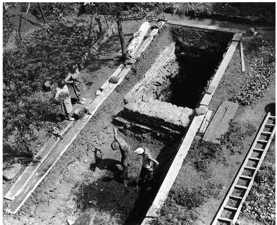
4: Blick auf den Sondierschnitt S1 und S2 ausserhalb der Kirche.
