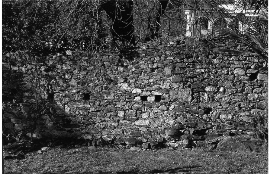
14: Ansicht der nördlichen Umfassungsmauer der Rocca von Süden.
