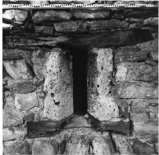
9: Ruine Resti. Aussenseite des östlichen Stubenfensters. Seitliche Gewände aus Tuff, Sturz und Fensterbank aus Nussbaumholz.
