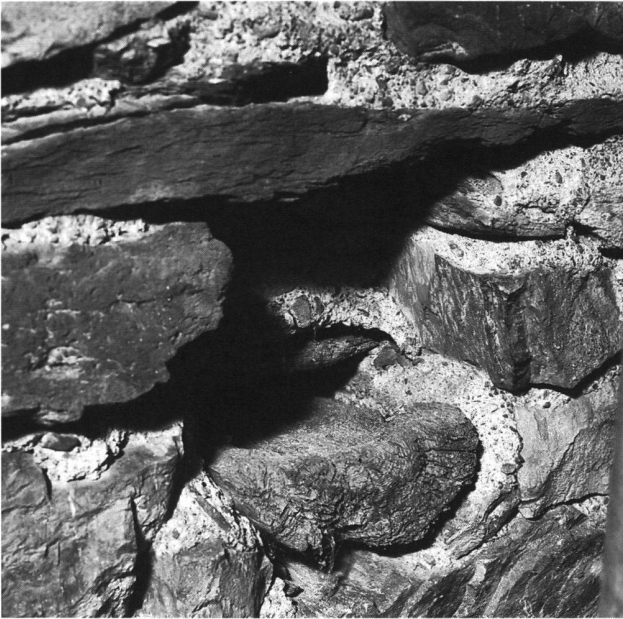
8: Ruine Resti. Einer der drei im originalen Mörtel der Zeit um 1250 liegenden hölzernen Ausgüsse mit Brettdeckel.
