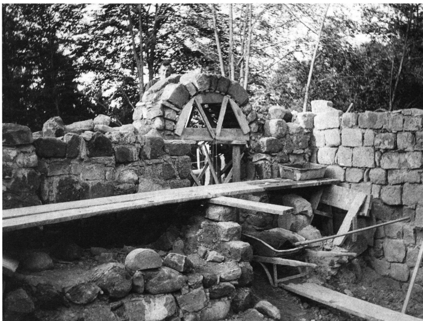
Burgruine Hünenberg: Arbeitsaufnahme bei der Rekonstruktion des Portalbogens, vermutlich 1945/46. Legende auf der Rückseite des Fotoabzuges: «Hinterer Ausgang des Pferdestalles» (Nachlass Emil Villiger).
