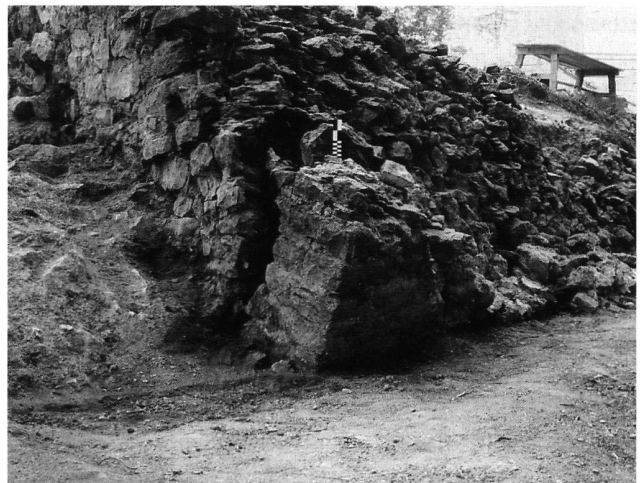
14: Altenberg. Bodensenkungen führten zum Abreißen des Aussenmantels auf einem längeren Abschnitt der Ringmauer.
