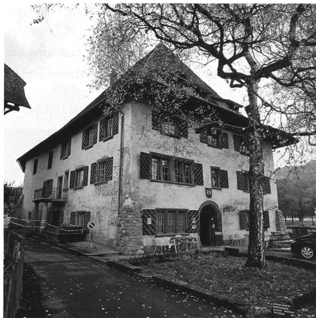
2: Das Grosse Höchhus vor der Sanierung. Aufnahme 2006.
