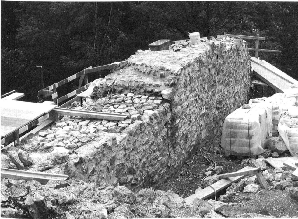
Abb. 5: Unterer Mannenberg. Wiederaufmauerung der obersten Mauerlagen. Blick auf die östliche Ringmauer von Norden.
