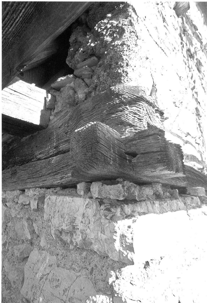
7: Überkämmt Kronbalken an der Südecke des Palas, vermutlich Auflager des Obergadens von 1375/1380, darüber Mauerschwelle des Dachstuhls von 1620–1622.
