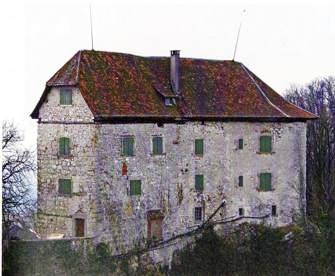
Plan 2B: Ansicht der Nordostfassade der Kernburg vor der Fassaden- sanierung 2008.
