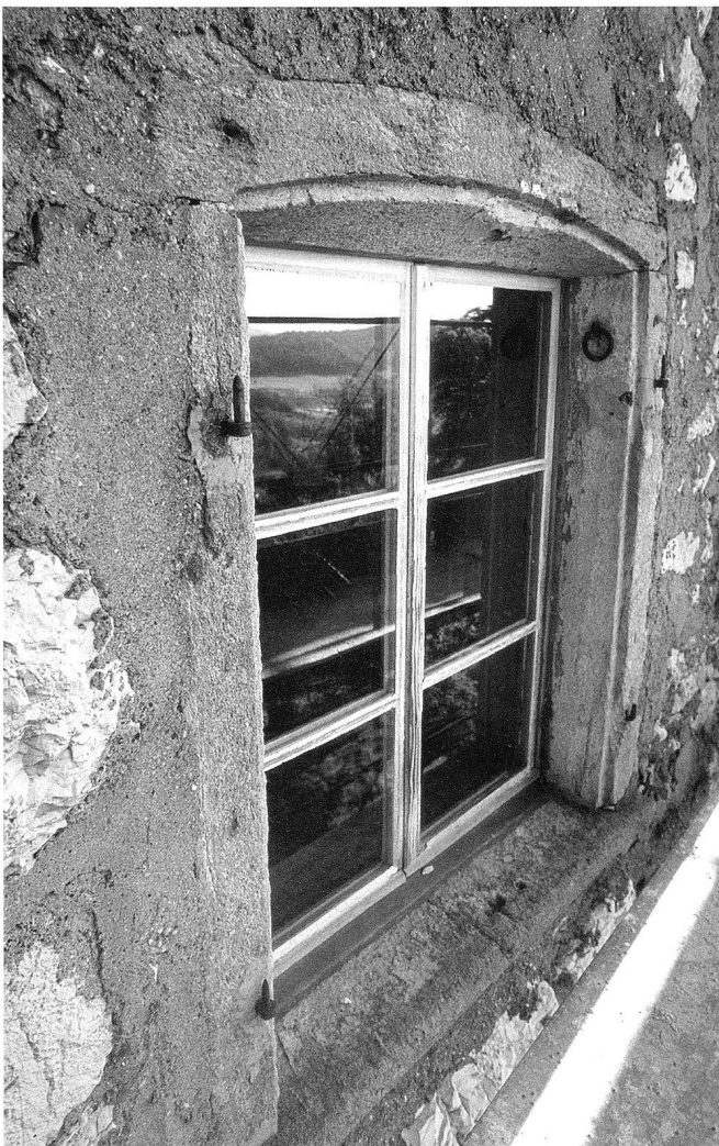
23: Fenstergewände aus Muschelkalkstein von 1805/1806 an der Südwestfassade des ehemaligen Hauptturms, von Westen.
