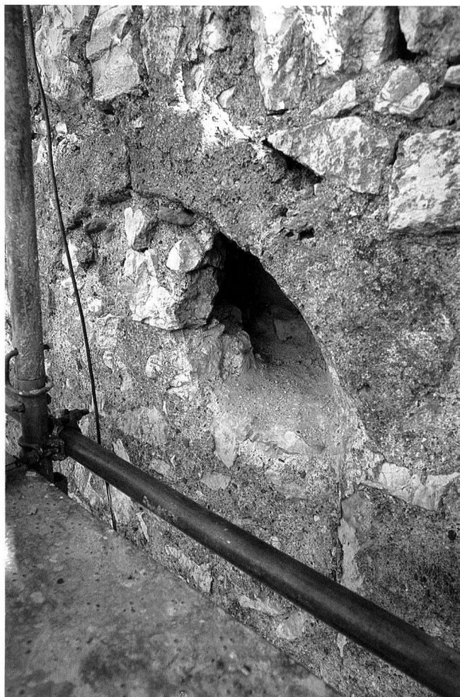
4: Rundbogenfenster an der Südwestfassade des Palas mit Gewänden aus Kalk- und Sturz aus Kalktuffstein, von Süden.
