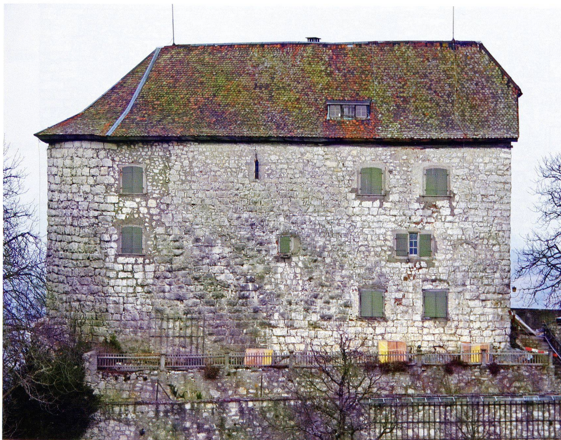
Plan 2A: Ansicht der Südwestfassade der Kernburg vor der Fassaden- sanierung 2008.
