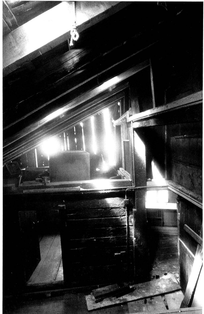
5: 1. Obergeschoss, hinterer Hausteil. Kammer in Ständerbohlenbauweise und Hochstud mit Firstpfette. Blick nach Norden.
