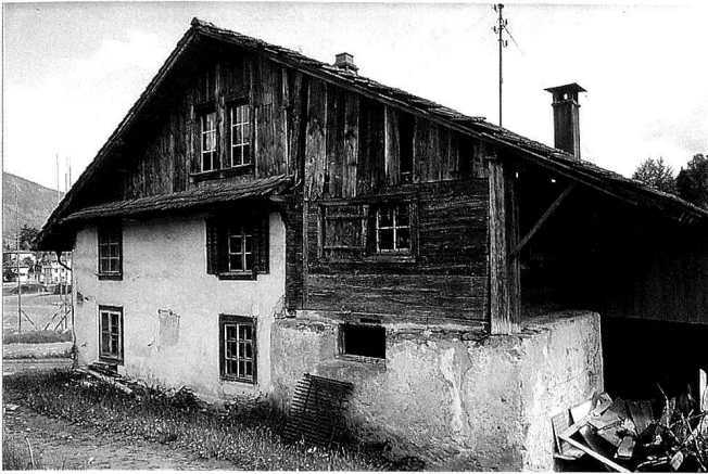
4: Rückansicht des Hauses. Gemauerter Sockel mit darüberliegender Kammer in Ständerbohlenbauweise. Blick nach Südosten.
