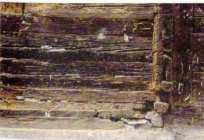
2: Südöstliche Ecke des erhaltenen Teils des Kernbaus. Sichtbar sind die fassadenbündigen Bodenbohlen und das Schwellenschloss. Rechts fügt sich der Anbau des 19. Jh. an. Blick nach Norden.
