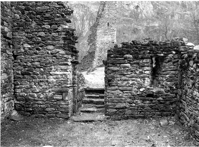
6: Kellerraum im Südteil des Palas, Blick gegen Westen.
