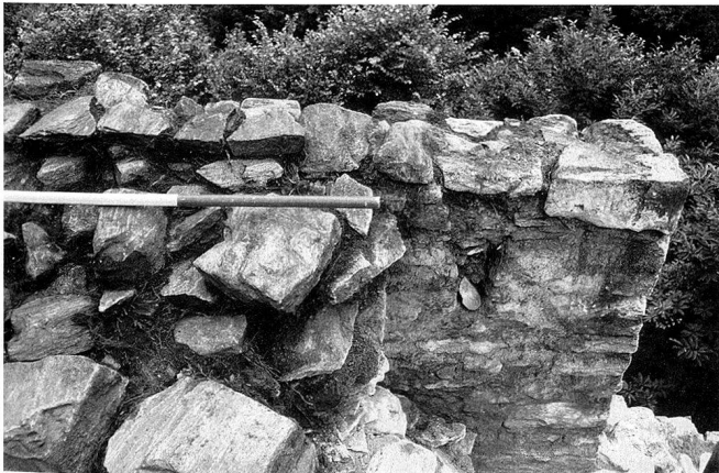
9: Aufhöhung des südlichen Wehrganges in der Phase 3. Osten.
