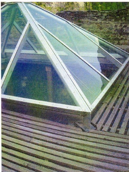
1: Das praktisch nicht einsehbare Dach mit Glaspyramide auf dem Hauptturm von Hohenrätien, Sils i. D. (Foto BVG).
