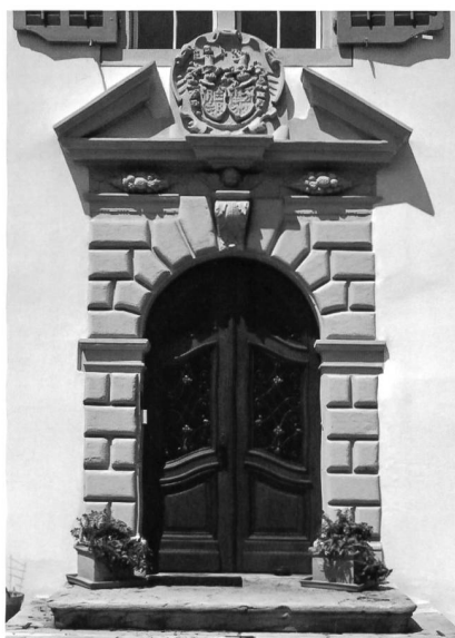
14: Reding-Haus an der Schmiedgasse (ab 1614), Schwyz SZ.
