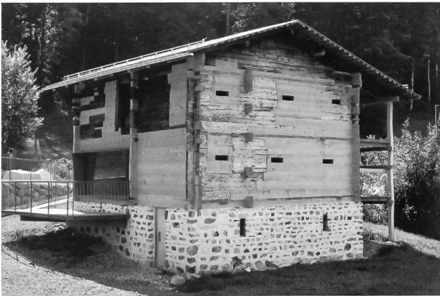
3: Morgarten, Oberägeri ZG. Die Hauptfront des mittelalterlichen Schwyzer Holzhauses. Beim Wiederaufbau wurde der Zustand von ca. 1270 wiederhergestellt.
