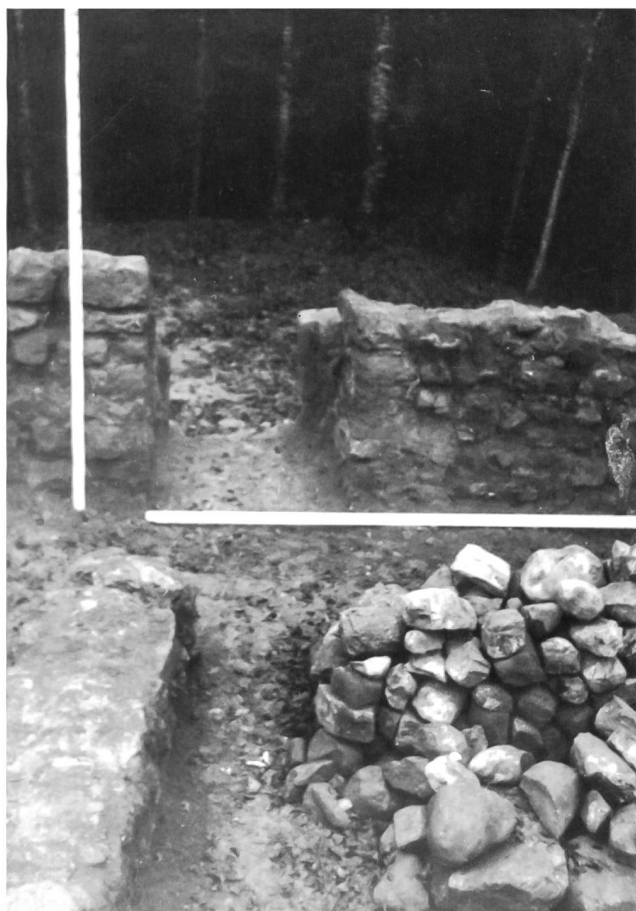
10: Die zusammen mit dem Zwinger errichtete Nordmauer der Burg war mit einer Poterne ausgestattet. Letztere hatte aber nur kurze Zeit Bestand und muss nach Erbauung einer querverlaufenden Mauer (vorne links) bereits wieder zugemauert worden sein. Fotografie der Altgrabung vom 21. November 1946.
