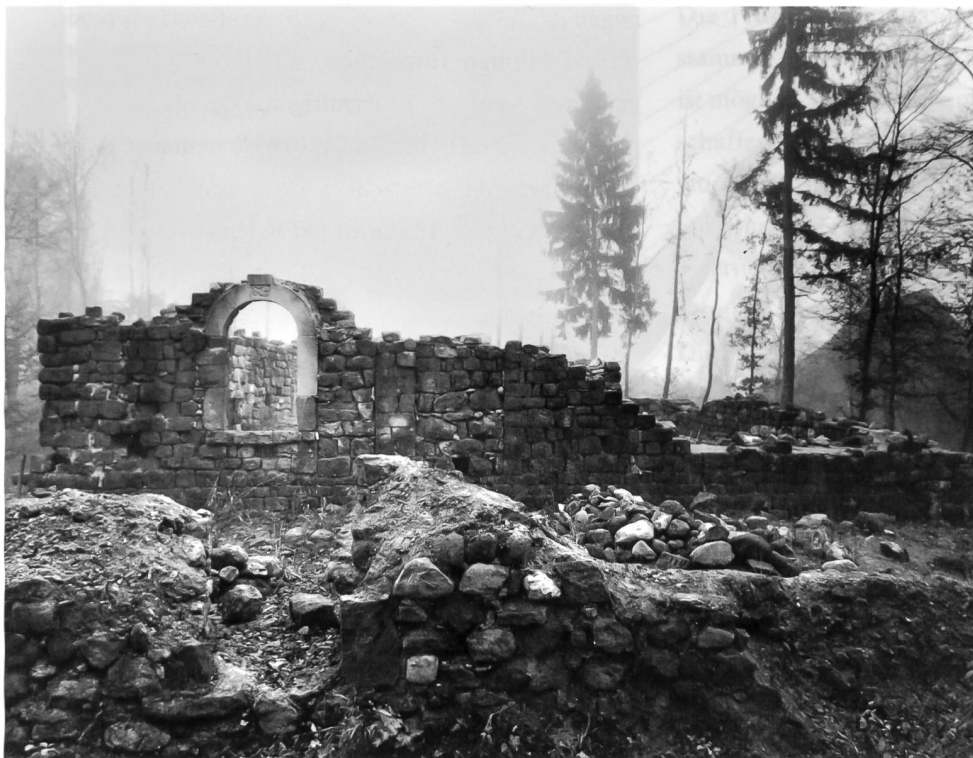
8: Einzelne Mauern wurden nach Abschluss der Grabung 1947 wieder neu aufgeführt. Ansicht der Südwand (Innenseite) des Palas von Norden her gesehen. In der Bildmitte zeichnet sich das sekundär zugemauerte Doppeltor mit dem Pfeiler ab. Das höher liegende Tor links davon stammt aus einer jüngeren Bauetappe und wurde nach Abschluss der Ausgrabung 1947 mit dem Bogen rekonstruiert. Fotografie der Altgrabung, wohl 1947.
