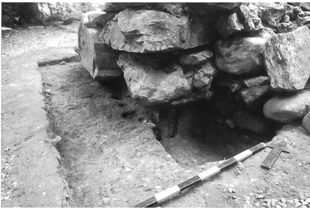
14: Die Vormauerung südlich des Bergfrieds diente wohl zur Aufnahme einer Zugbrücke. Der über die ältere Ringmauer vorkragende Mauerabschnitt wurde mit zahlreichen Staketen unterstützt.
