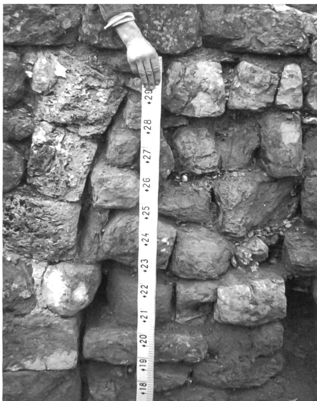
5: Westfassade des Torgebäudes. Links im Bild sind die Ansätze eines Tuffsteinbogens zu erkennen. Das Tor war rund 2,5 m breit. Fotografie der Altgrabung 1945–1947.
