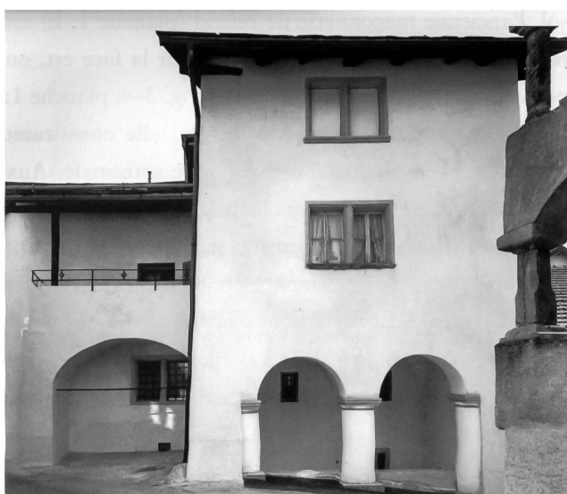
6: Maison Guerrati, façade nord après les travaux de rénovation – Ansicht der Nordfassade nach den Renovationsarbeiten.
