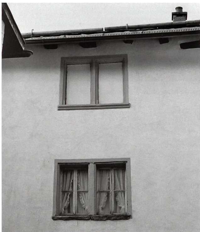
11: Maison Guerrati, façade nord. Détail de la fenêtre au cadre mouluré du 2 e étage, après les travaux de 2001 – Zustand der Nordfassade nach den Sanierungen ohne Dekormalerei.
