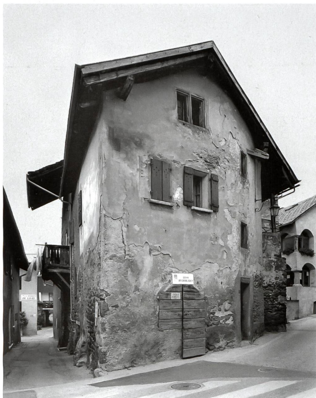
3: Maison Guerrati, façade orientale avant les travaux de rénovation de 2001 – Ansicht der Ostfassade vor den Sanierungsarbeiten von 2001.
