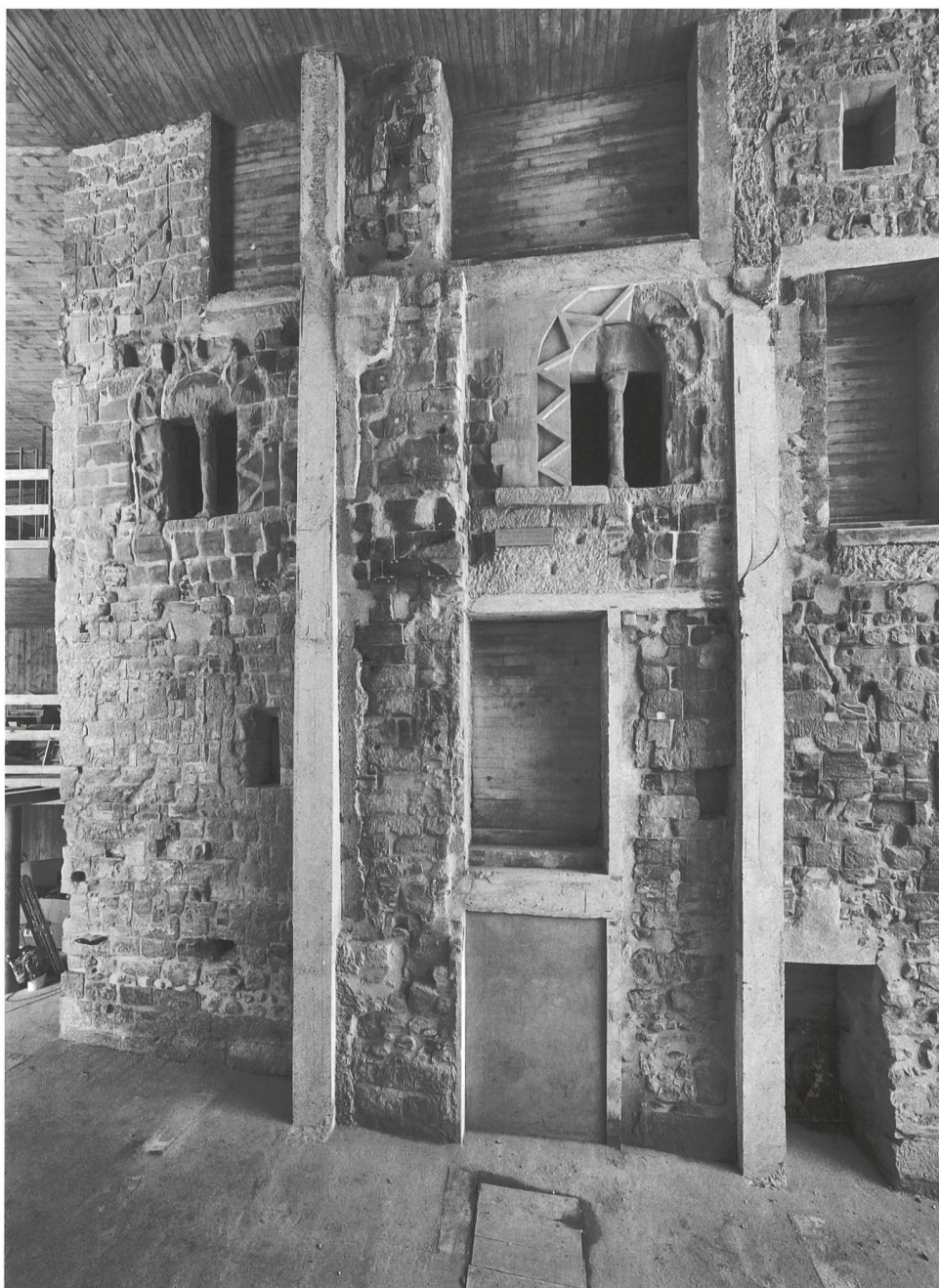
1: Lausanne, maison Charbon. Façade sud dans le hall d'entrée actuel du parlement, avant l'installation de l'escalier monumental.
