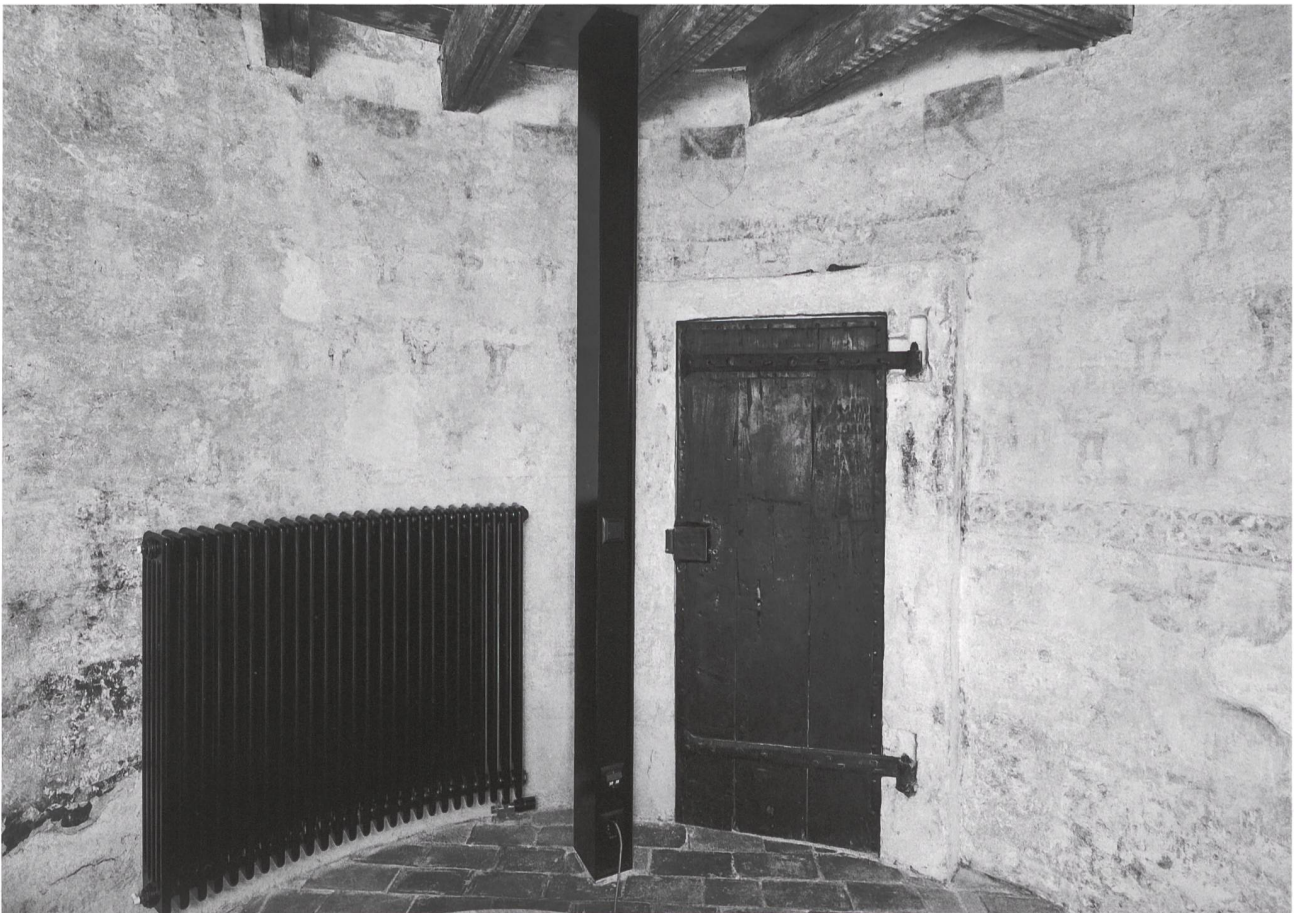
9: Lausanne, Saint-Maire. Tourelle sud-ouest après conservation des décors. Au-dessus de la porte apparaît la frise armoriée des Challant, après 1416.
