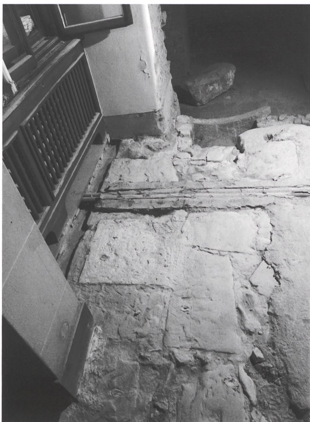
5: Lausanne, Saint-Maire. Reste du sol du chemin de ronde occidental. La maçonnerie sommitale de la façade est constituée de grosses pierres plates ayant servi de dallage.
