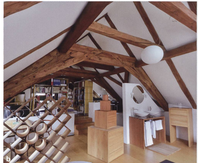
17: Chur. Liegende Dachstühle in Wohnhäusern aus dem letzten Viertel des 16. Jh. a Comandergasse 3, 1587d; b Rabengasse 4, 1593d.
