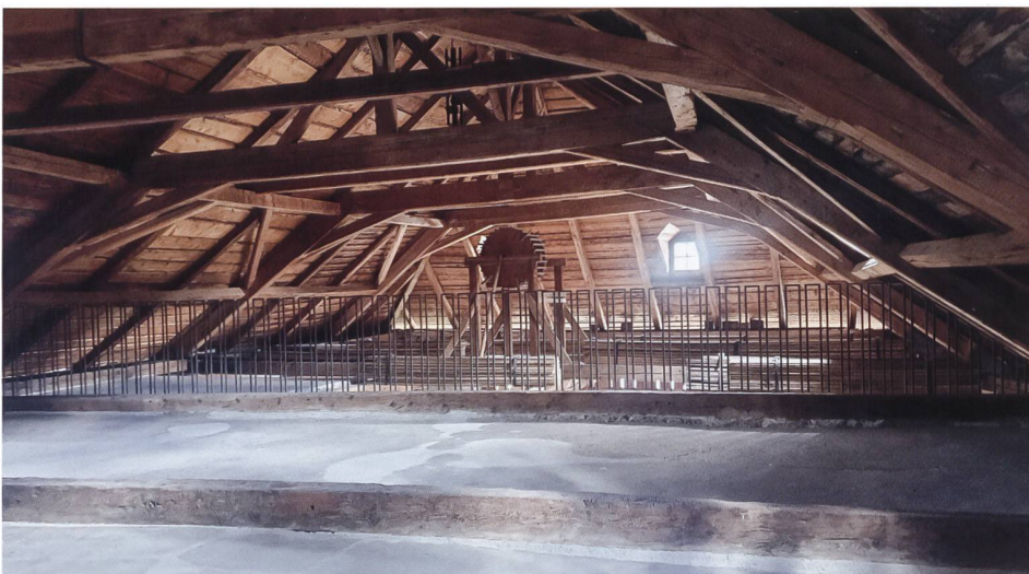
19: Zuoz, Chesa Gregori. Liegender Dachstuhl mit eingezapften Kopfstreben von 1791d. Blick gegen Süden.
