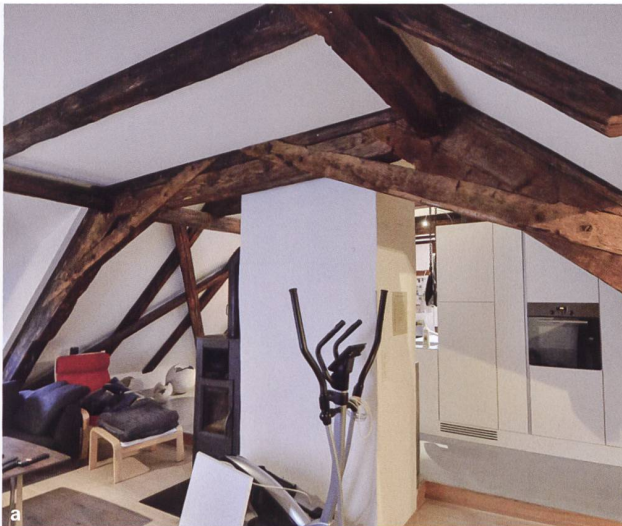
17: Chur. Liegende Dachstühle in Wohnhäusern aus dem letzten Viertel des 16. Jh. a Comandergasse 3, 1587d; b Rabengasse 4, 1593d.
