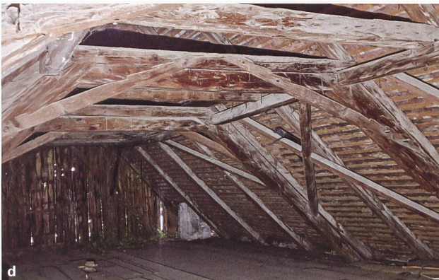
15: Chur. Die Dachstühle der Torkel: a Unterer Neubruchtorkel, liegend mit Hängewerk, 1582d; b Kronentorkel, liegend, 1593d; c Katzorkel, liegend, 1601d; d Brändlitorkel, liegend, 1601d; e Weisstorkel, liegend, 1604d; f Ragatzertorkel, undatiert (die dichte Abfolge der Binderbalken lässt auf einen liegenden Dachstuhl schliessen); g Maiertorkel, undatiert (mit stehendem Dachstuhl).
