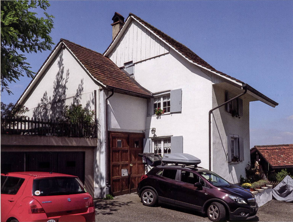
18: Liegenschaft Geispelgasse 20. Das ursprünglich einachsige Gebäude wurde durch den Anbau eines Tennis zum zweiachsigen Bauernhaus. Foto 2020.
