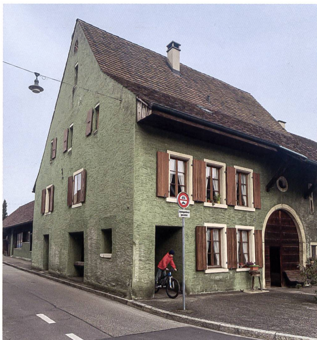
10: Liegenschaft Hauptstrasse 45. Das kantonal geschützte Gebäude musste wegen einer Strassenverbreiterung auf die Stube im Erdgeschoss verzichten. Foto 2022.
