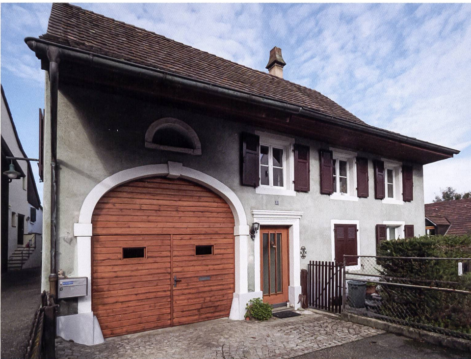
13: Liegenschaft Geispelgasse 8. Beispiel für ein zweiachsiges Bauernhaus. Die Fassade wurde im 19. Jh. umgestaltet und eine Haustüre eingebaut. Foto 2020.
