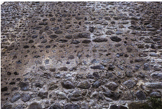
8: Häggenschwil SG, Ruine Alt Ramschwag. Schildmauer Aussenfassade. Mauerabschnitt SM1 mit qualitativem Rasa-Pietra-Putz mit Fugenstrich 1.17. Aufnahme 2024, von Südosten.
