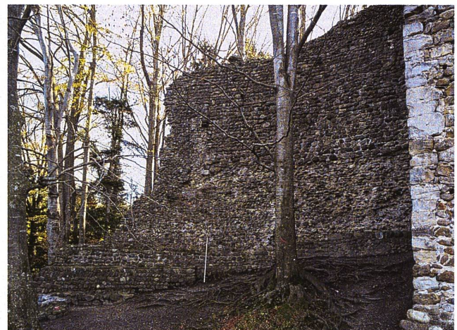
12: Häggenschwil SG, Ruine Alt Ramschwag. Innenfassade der Schildmauer (Profil P2). Blick auf die mehrfach ausgebesserte Fassade mit dem horizontalen Streifen an offen liegendem Kernmauerwerk des Mauerabschnitts SM2. Drei Viertel des darüber aufgehenden Innenmantels des Mauerabschnitts SM3.2 wurden um 1930 wiederaufgeführt. Aufnahme 2013, von Westen.
