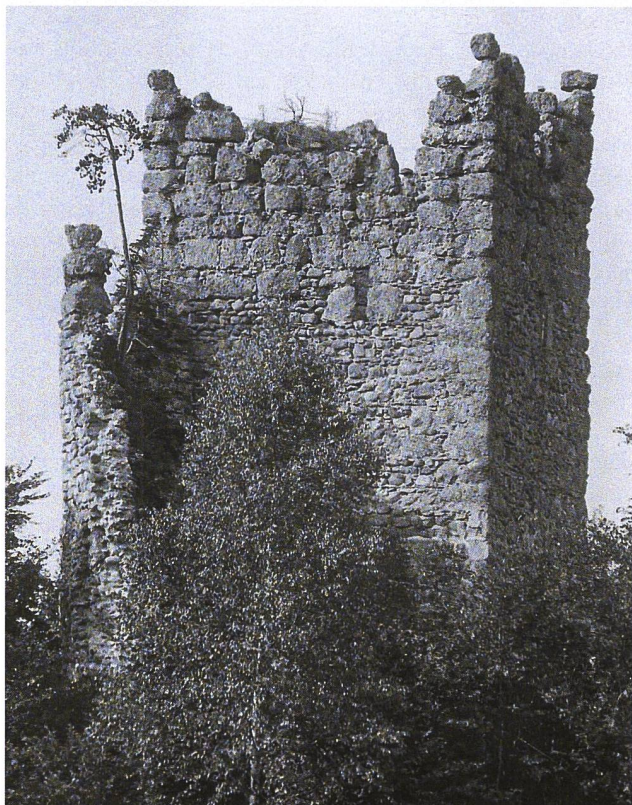
47: Häggenschwil SG, Ruine Alt Ramschwag. Aufnahme von Schildmauer und Turm um 1900. Auf der Schildmauer sind noch Reste der 2. Aufstockung SM4 aus Nagelfluhquaden vorhanden. In der Mauer M11 des Turms sind das Schartenfenster 11.2 im 3. Obergeschoss und die Öffnungen 11.3 und 11.4 im 4. Obergeschoss zu erkennen. Aufnahme um 1900, von Nordosten.
