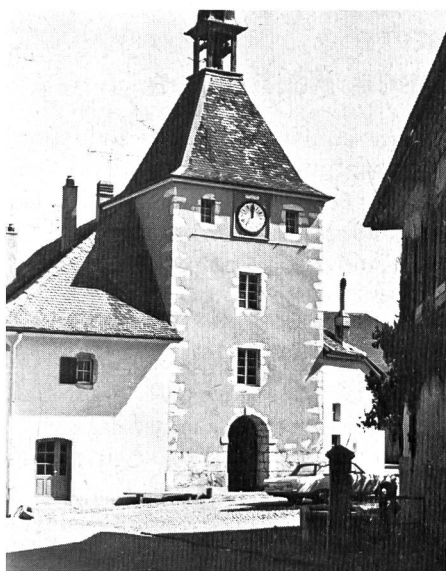
Tour ancienne à Valeyres-sous-Rances
