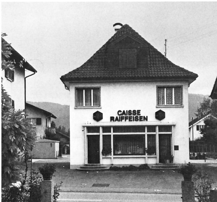
Le bâtiment de la Caisse Raiffeisen de Courroux-Courcelon s'intègre parfaitement aux alentours.
