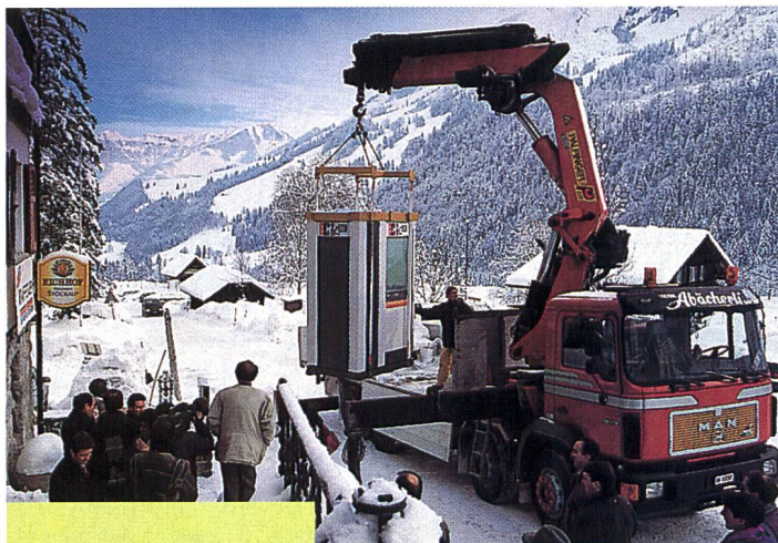
Le «city-cash-point» monté à l'aide d'une grue.
