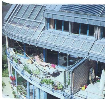
**La bonne combinaison: des capteurs solaires (pour le chauffage), des cellules solaires (pour l'électricité) et un concept réaliste offrent à cette maison solaire à quatre logements tout son attrait.**
