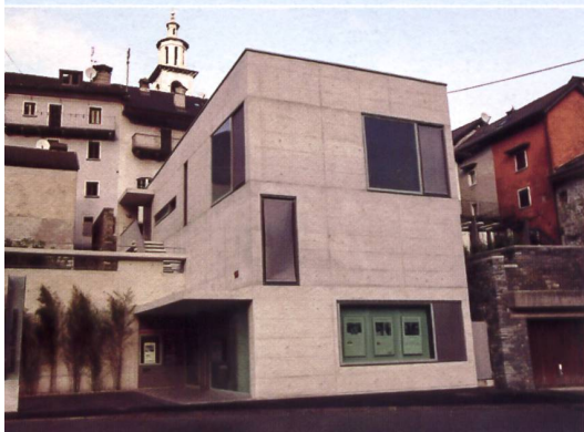
Le bâtiment d'Intragna abrite le siège social de la BR Centovalli Pedemonte Onsernone.
