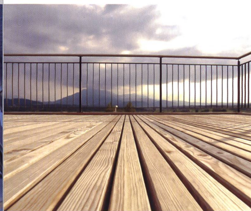
Recours fréquent au bois même sur le balcon qui sèche très rapidement.
