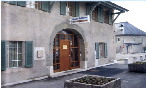
Facilement accessible en voiture, la banque à Confignon dispose désormais de nouveaux locaux fonctionnels et modernes.
