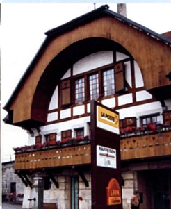
La ferme communale abrite les nouveaux locaux de la banque.
