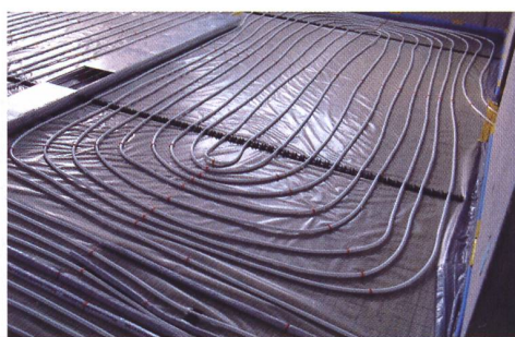
En ce qui concerne le chauffage au sol, la circulation d'eau à basse température nécessite une densité élevée de serpents.
