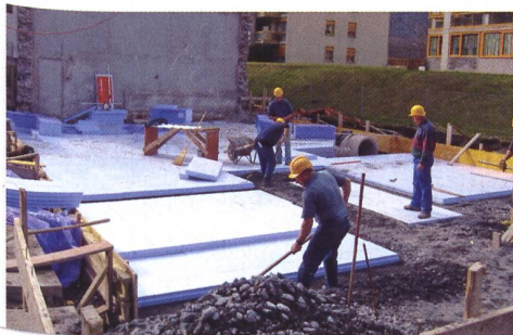
Sur des fondations parasismiques, les plaques d'isolation sous le radier atteignent 20 centimètres d'épaisseur.
