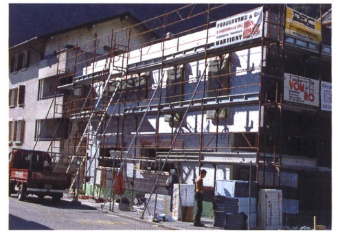
L'isolation en façade atteint 24 centimètres d'épaisseur.
