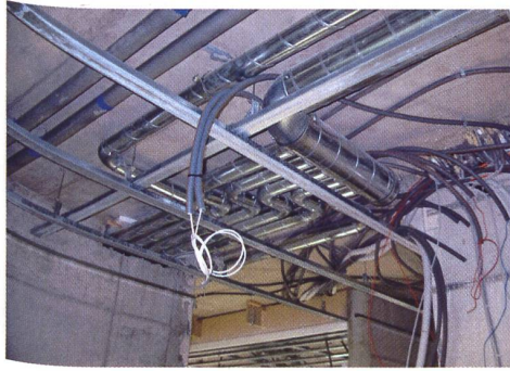
La ventilation contrôlée dans toutes les pièces a nécessité la pose de nombreuses canalisations dans les faux plafonds.
