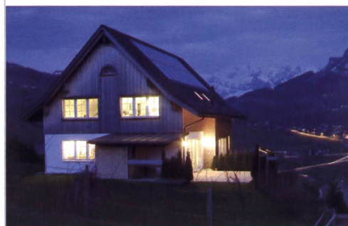
Maison MINERGIE® dans le Toggenburg avec capteurs solaires.
