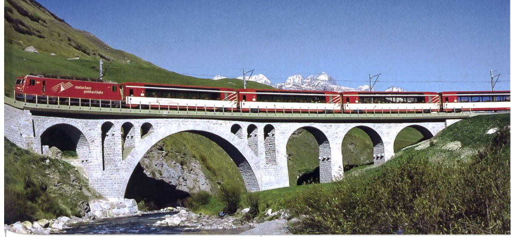
La Matterhorn Gotthard Bahn sur le pont Richleren entre Andermatt et Realp.
