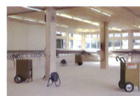
Assèchement des bâtiments
