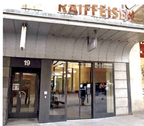
Nouvelle agence près de la Gare Cornavin.
