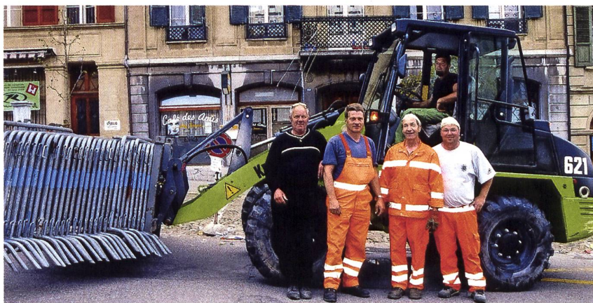
Plus de 800 barrières doivent être installées pour sécuriser le parcours dans Romont.
