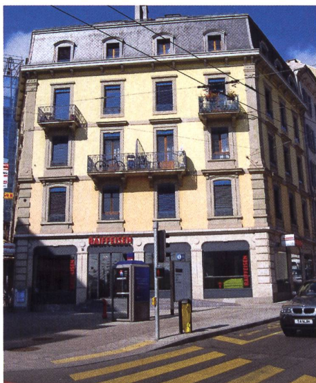
La nouvelle agence est située sur un axe de passage stratégique, près de la gare de Cornavin.
