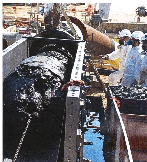
L'outil de nettoyage sorti d'une imposante conduite.
