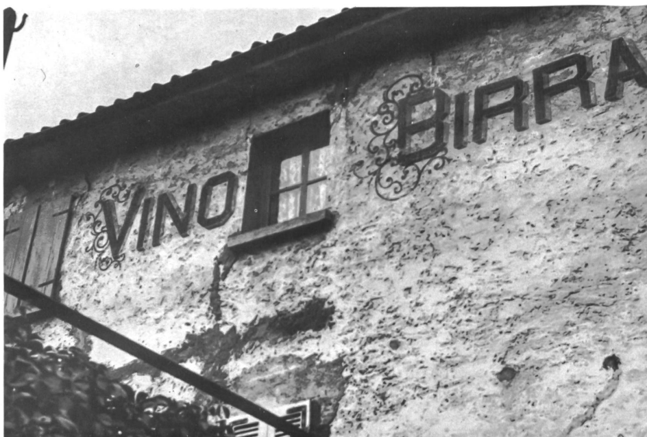
La facciata dell'edificio postale di Lodrino con la scritta cui l'articolo del prof. Flavio Bernardi fa accenno.
