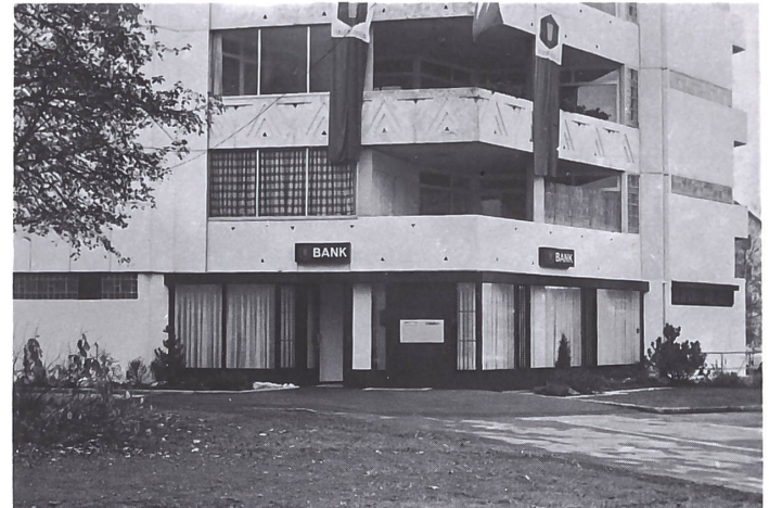
A fine 1977 la Cassa Raiffeisen lucernese di Littau (11,15 milioni di bilancio, 72,7 milioni di movimento e 270 soci per il 1976) ha inaugurato la propria nuova sede, provvista di tutte le moderne attrezzature bancarie.
