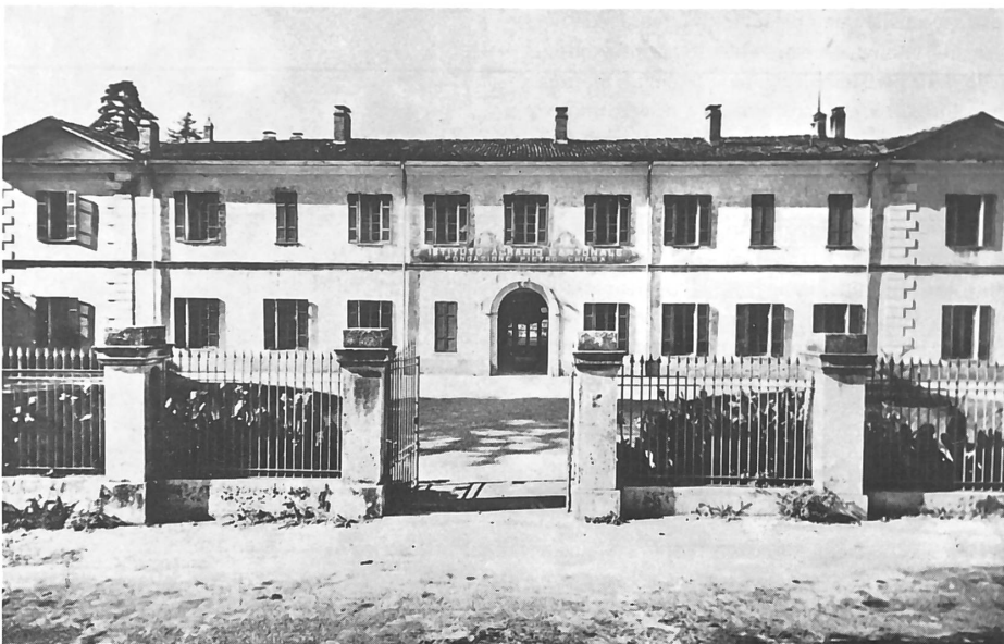
La Villa Cristina in Mezzana, ora Istituto Agrario Cantonale.
