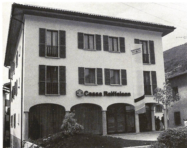
Lo stabile della Cassa Raiffeisen di Bioggio che ha concluso il trentesimo anno di attività con un bilancio di 15,5 milioni ed un effettivo di 251 soci.
