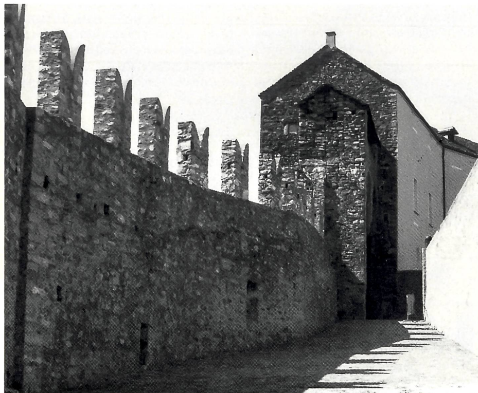
Due aspetti delle fortificazioni del Castel Grande a Bellinzona. I merli ghibellini e la sistemazione generale sono d'età posteriore.
