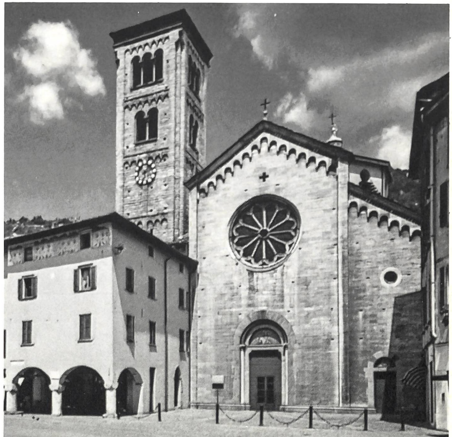
La chiesa di San Fedele a Como: facciata sulla piazza.
