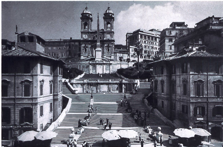
Roma: la famosa scalinata della Trinità dei Monti, edificata con la collaborazione di Domenico Fontana.
