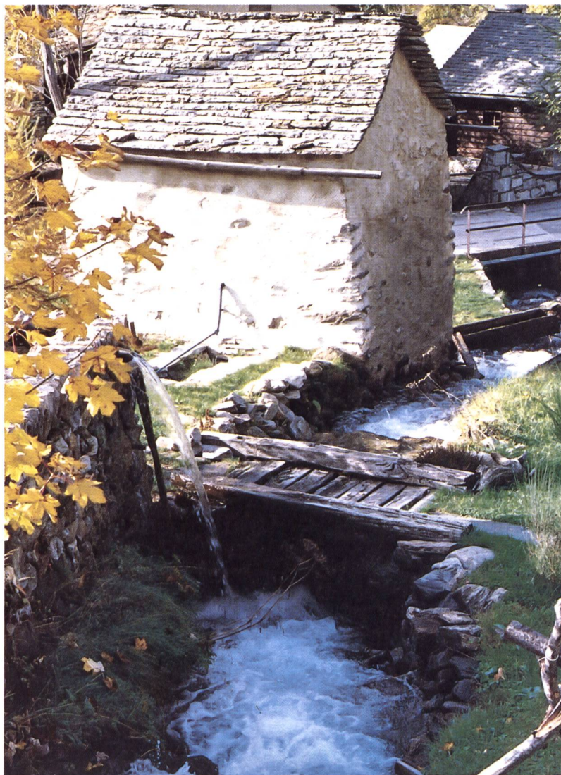
Centralina di Mogno con imponente sorgente a lato del pozzo di raccolta.
