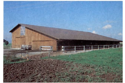
Il nuovo fabbricato dell'azienda comunitaria: lungo 50 m e largo 28,5 m è un imponente edificio alla periferia di Niedermuhren.
