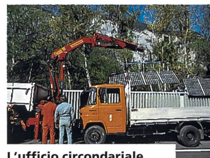
L'ufficio circondariale delle costruzioni di Coira ha dimostrato una collaborazione esemplare tra la Confederazione, il cantone e l'economia privata nel montaggio di pannelli ad energia solare lungo la A13.
