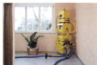
Prosciugamento dei danni dell'acqua
