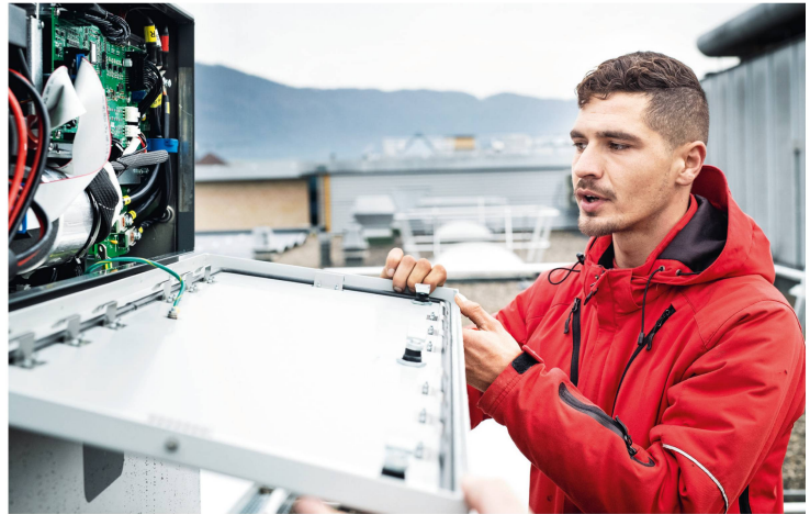
L'impianto solare consente di coprire quasi integralmente il fabbisogno energetico.
