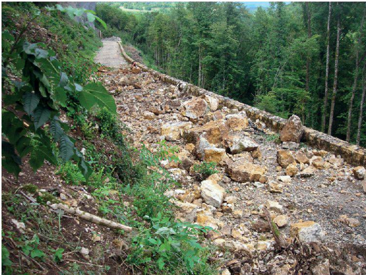
Figure 9.–Purges manuelles et mécaniques (Chatillon); photo BG / Hugues Foltzer.
